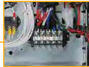
Dış ünite güç besleme terminal bloğu
