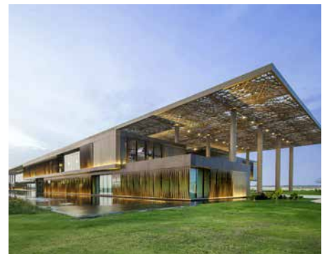
Data Center - Senegal
