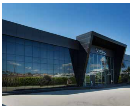
Selüz Kimya Fabrikası - Kocaeli
